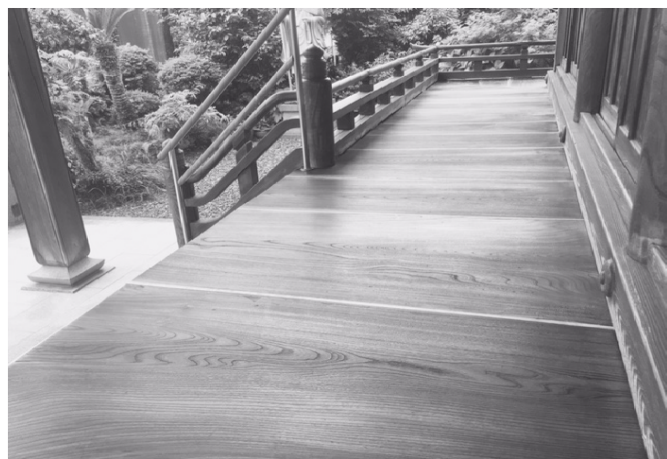
きれいに修理していただいた縁側
